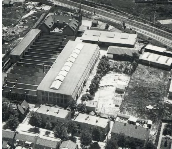
Jaarsmafabriek met sheddaken
